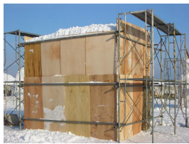
①枠組み～雪入れ
